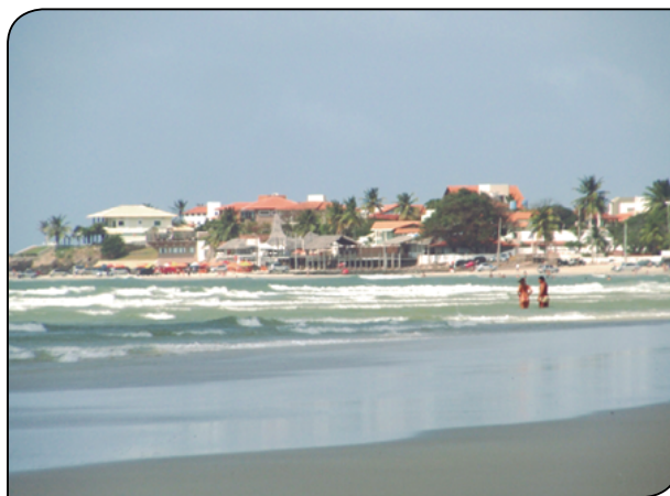
Figura 12. Edificações na praia do Farol Velho.
