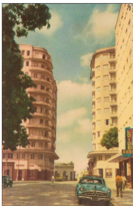
Figura 2. Cartão Postal da década de 1950, com destaque à esquerda ao Edifício Piedade e à Direita ao “Renascença”.
