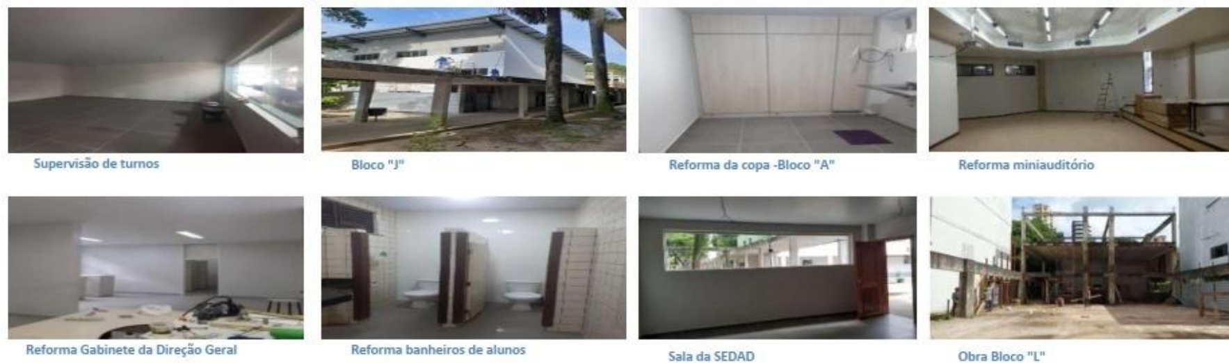
Figura 8 - Obras e serviços
