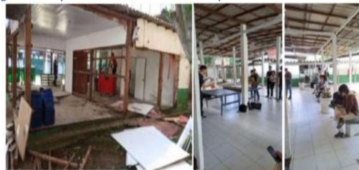
Figura 23 - Depósito do Patrimônio antes e depois do desfazimento
