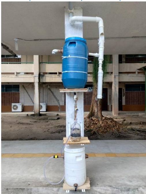
Figura 31 - Protótipo de sistema simplificado de aproveitamento de águas pluviais.
