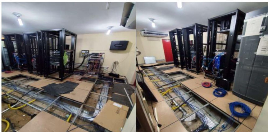
Figura 26 - Visão do CPD durante o processo de reforma
